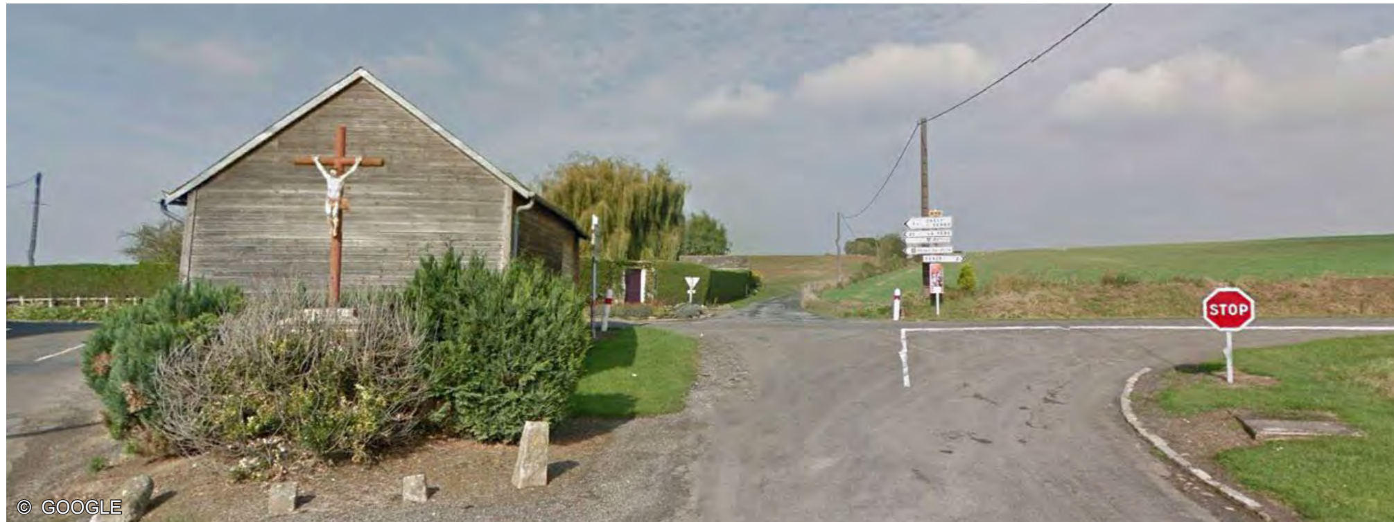
Fig. 161 : Vue du calvaire de Mortiers - avant les travaux d'embellissement paysager
