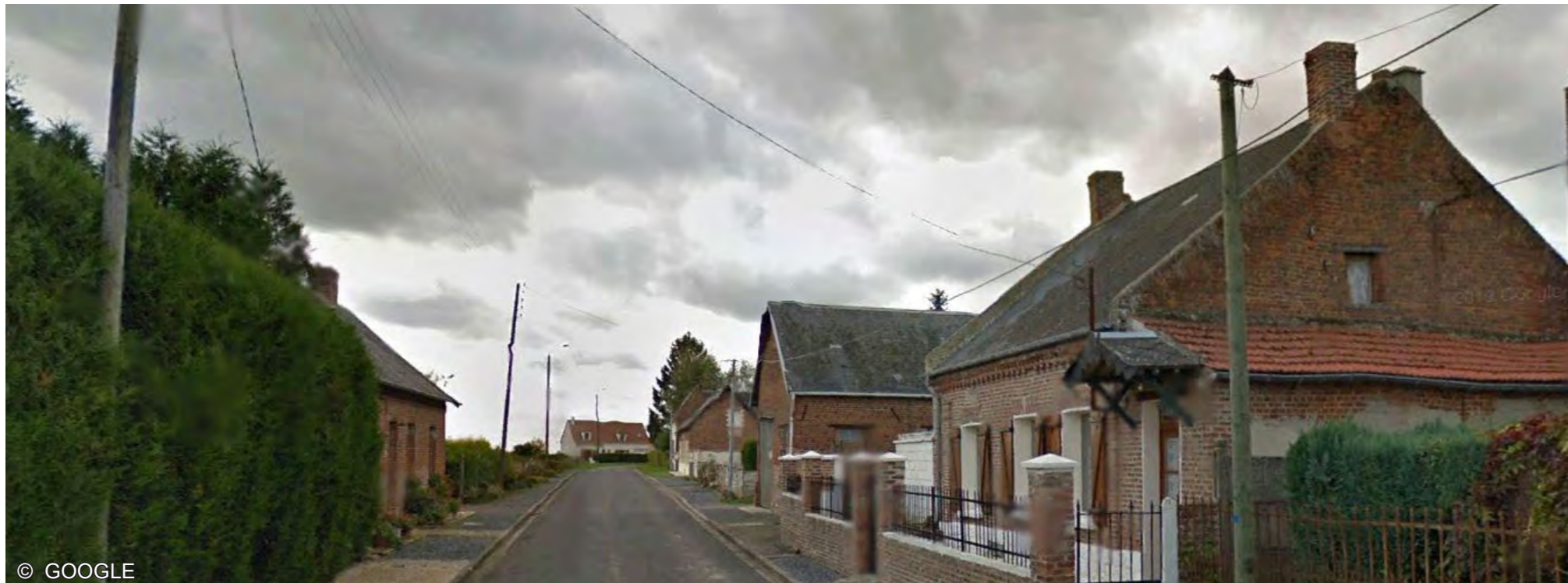
Fig. 159 : Vue de la rue Marcel Carlier - avant l'enfouissement des lignes électriques
